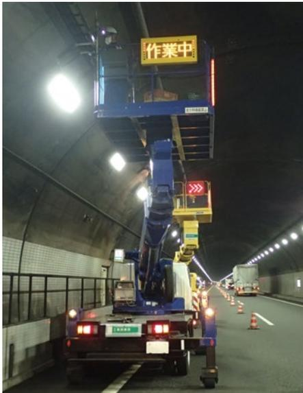
高所作業車の作業台部分に設置することにより、走行車等への注意喚起を促します。
