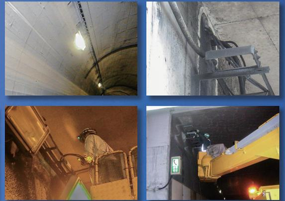
高速道路のトンネル内灯具のケーブルラック結束や、融雪剤散布車などの架装車両の配線結束など採用事例多数
